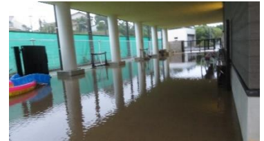
【水浸しのピロティ】
